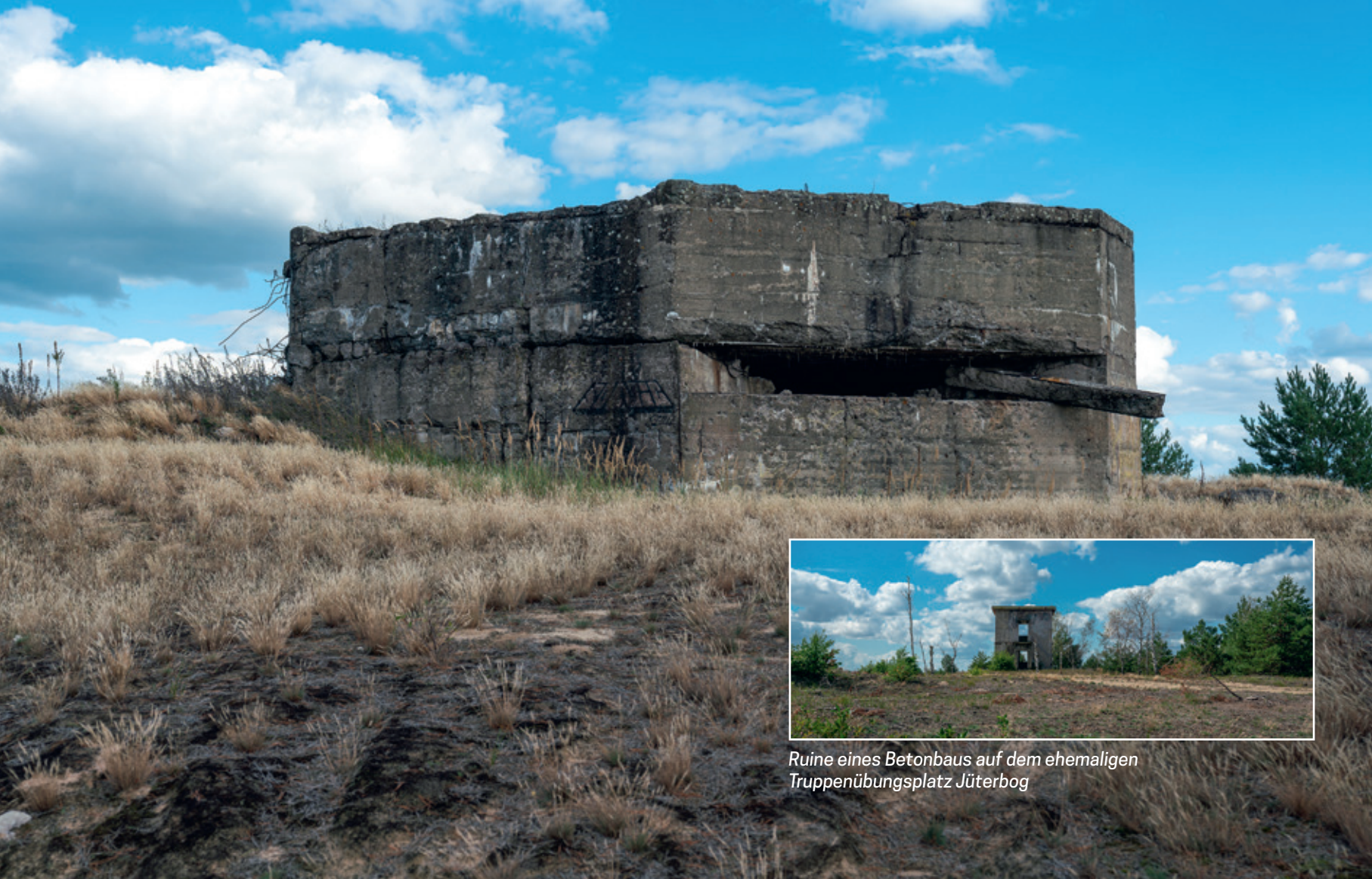
Betonbunker auf dem ehemaligen Truppenübungsplatz Jüterbog
