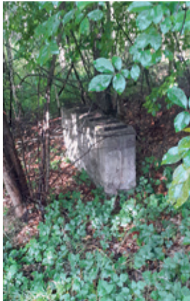
Reste des Fernwärmeheizsystems
